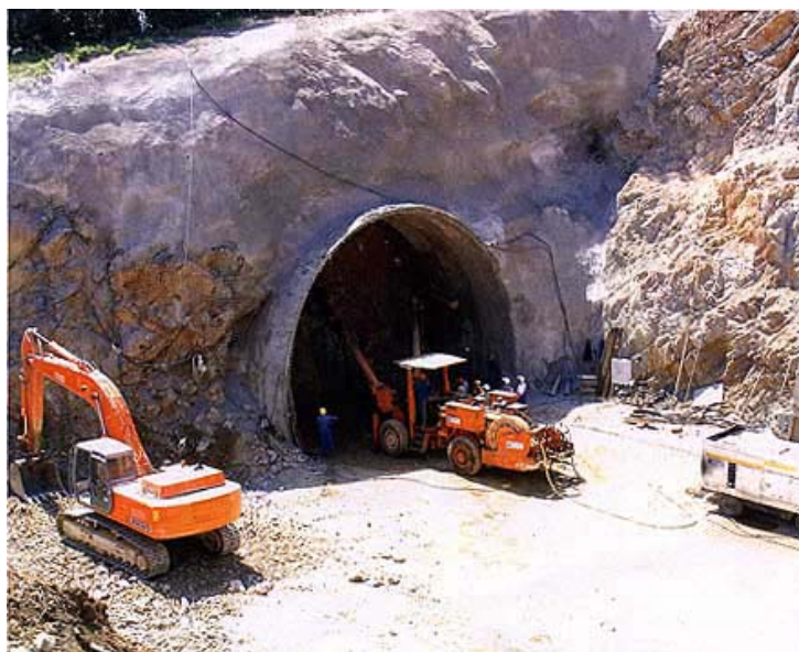
Početak proboja tunela na Jurdani
